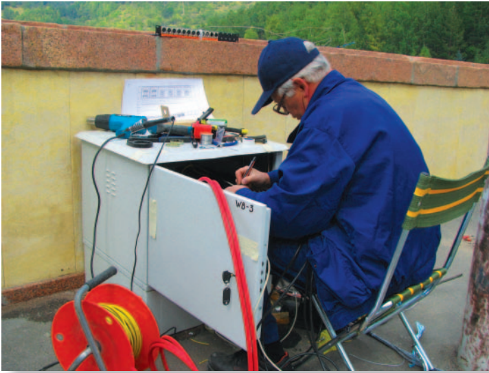
ВСК «Медео», (Алматы): монтаж триаксиальных соединений
